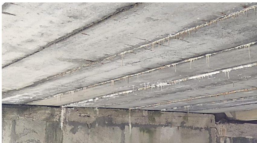
Рисунок 11 — Інтенсивне вилугування плит у вигляді сталактитів
