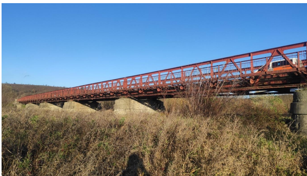
Рисунок 1 — Вид на малі ферми з паралельними поясами
