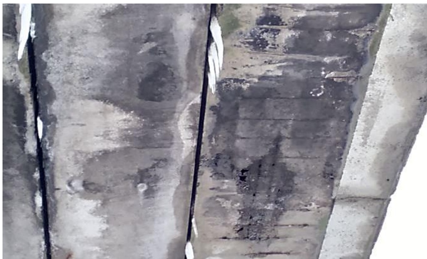
Рисунок 13 — Наскрізні руйнування бетону нижньої грані плити, оголення та корозія арматурного каркасу. Затікання води
