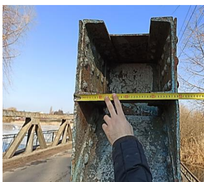
Рисунок 6 — Верхній пояс Ф1 по торцю з боку центра м. Андрушівки
