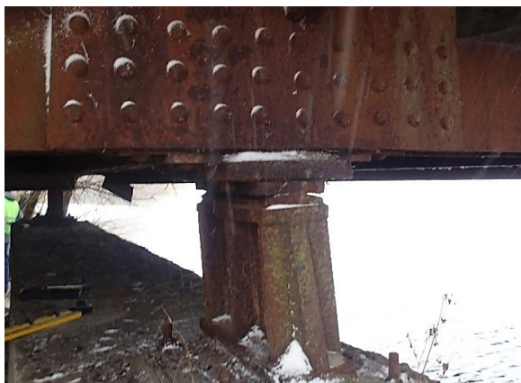
Рисунок 15 — Валкова рухома опорна частина на ОП № 2
