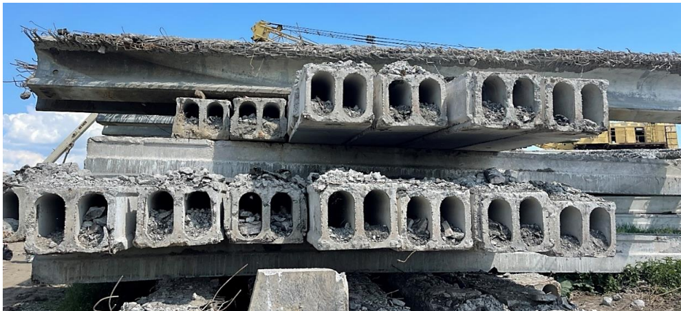
Рисунок 3 — Загальний вид на переріз плит ВТП-21
