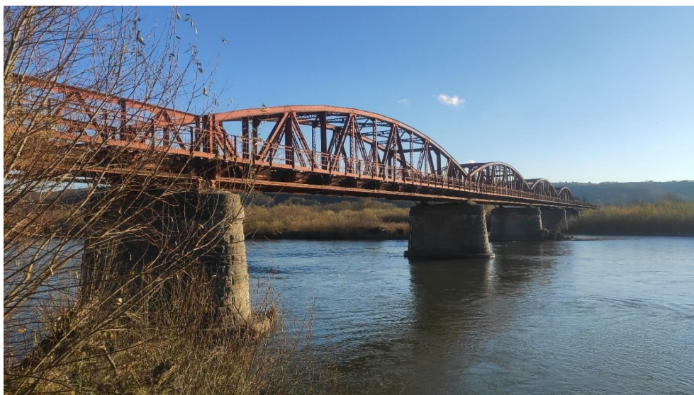
Рисунок 2 — Вид на великі полігональні ферми
