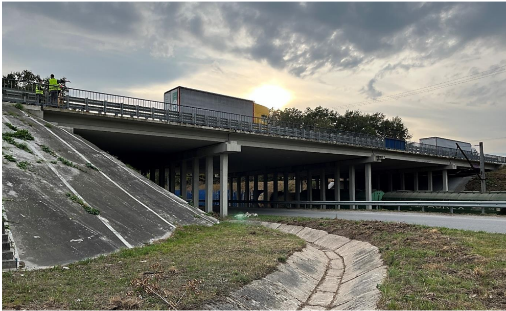
Рисунок 1 — Вид на фасад шляхопроводу, виконаного із збірних плит за типовим проектом ВТП-21
