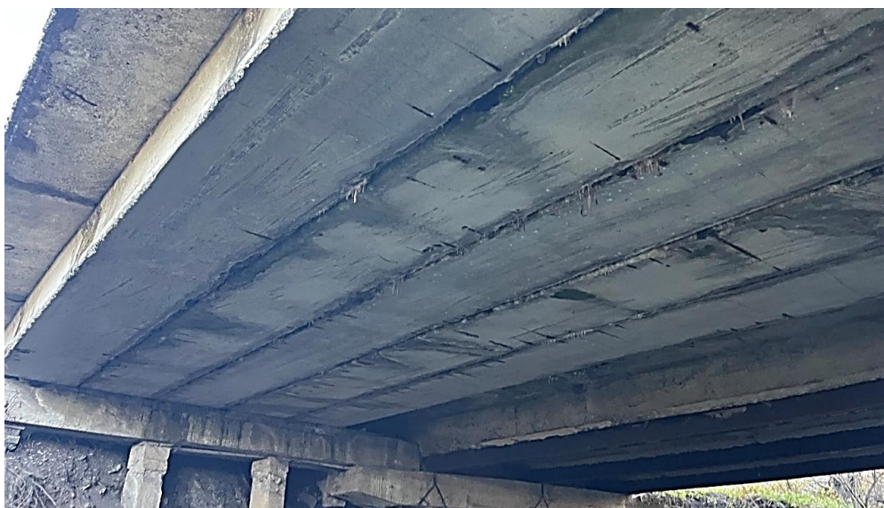
Рисунок 4 — Загальний вид на поширення старого сталезалізобетонного мосту плитами ВТП-21
