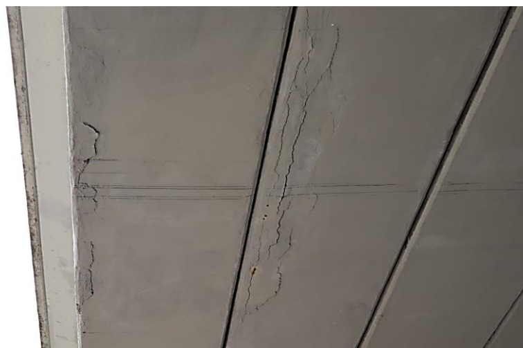
Рисунок 14 — Відшарування захисного шару бетону внаслідок корозії арматури плити
