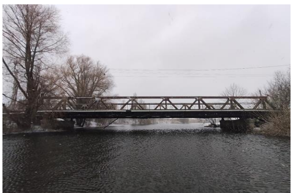
Рисунок 3 — Загальний вигляд мосту з верхової сторони
